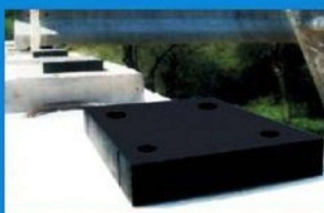
APOYO PARA PUENTE
