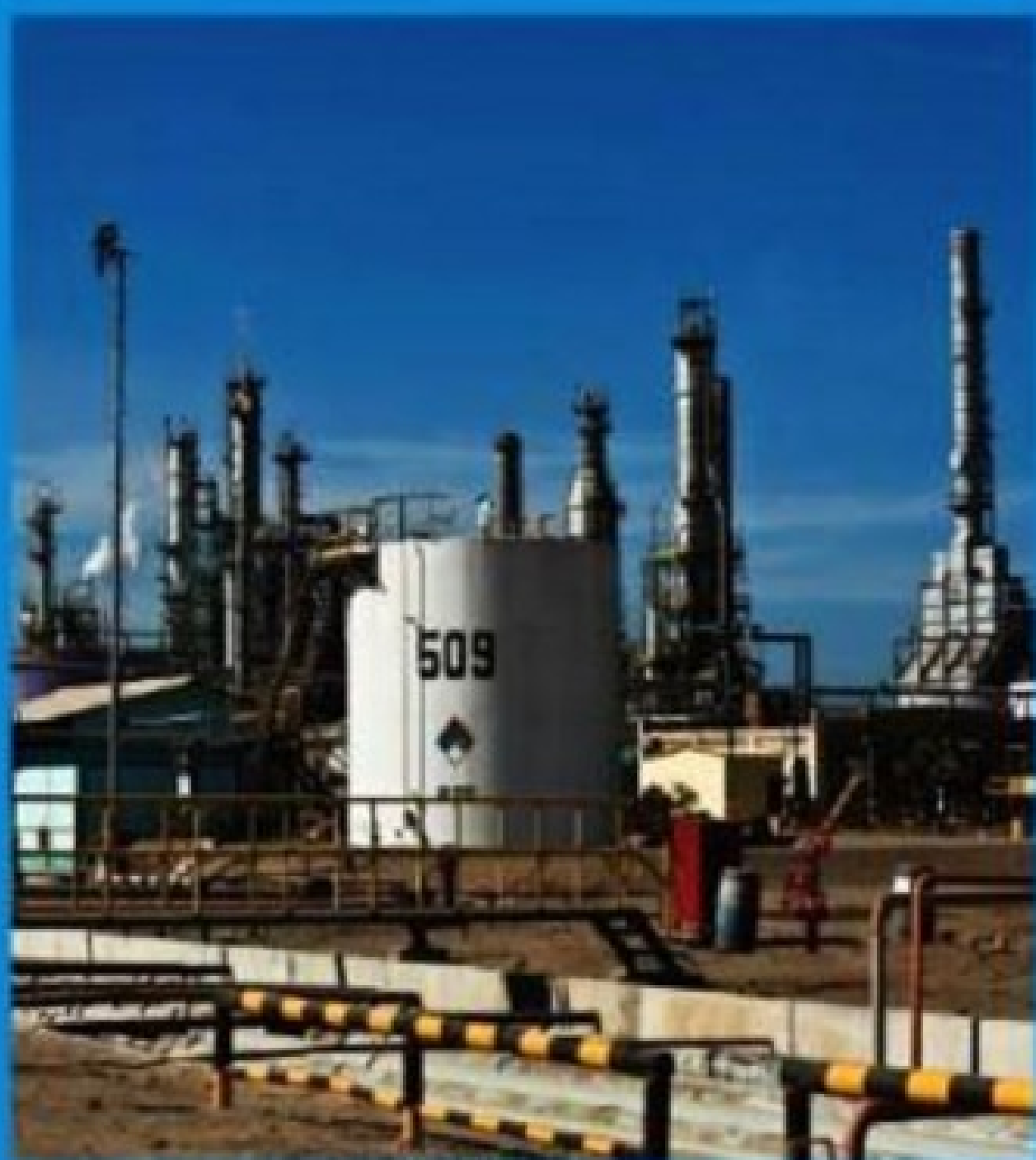
PetroPeru Refinería Talara - Constructora Grupo Sotoval Peru
